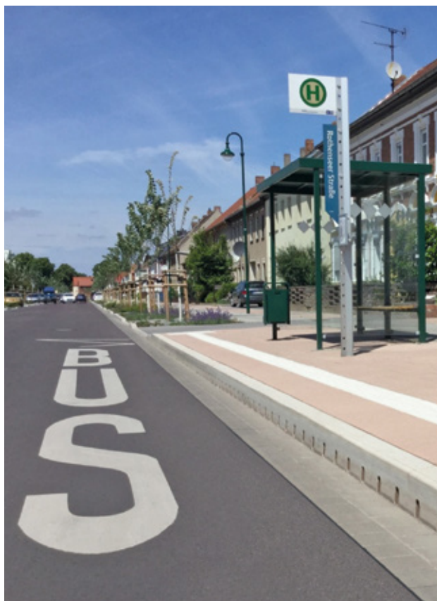
Subida al autobús sin barreras gracias a la plataforma de 18 cm de altura
