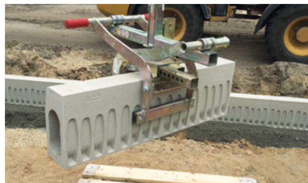
■ Las pinzas facilitan el desplazamiento de los elementos
