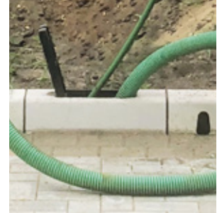
■ Lavado del elemento de inspección
