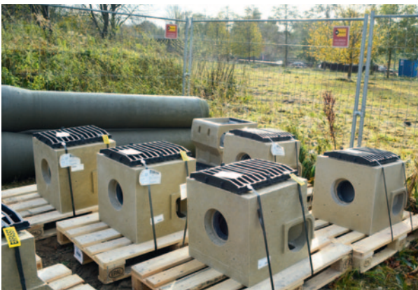
Elementos deflectores a punto para instalar Elementos de defletores prontos para instalação
