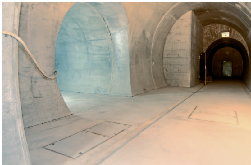
Tapas ACO Secant empleadas como tapas de registro en el túnel de Wattkopf Tampas ACO Secant utilizadas como tampas de registo no túnel de Wattkopf
